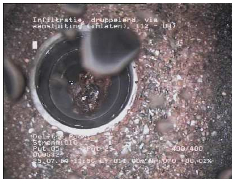
FOTO 070 11.00 m Video DVD01 Infiltratie, druppelend, via aansluiting (inlaten)
