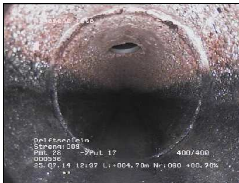
FOTO 060 4.80 m Video DVD01 Infiltratie, doorzweten, via voegen tussen buizen
