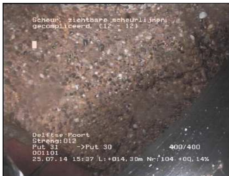
FOTO 104 14.30 m Video DVD01 Scheur, zichtbare scheurlijnen, gecompliceerd
