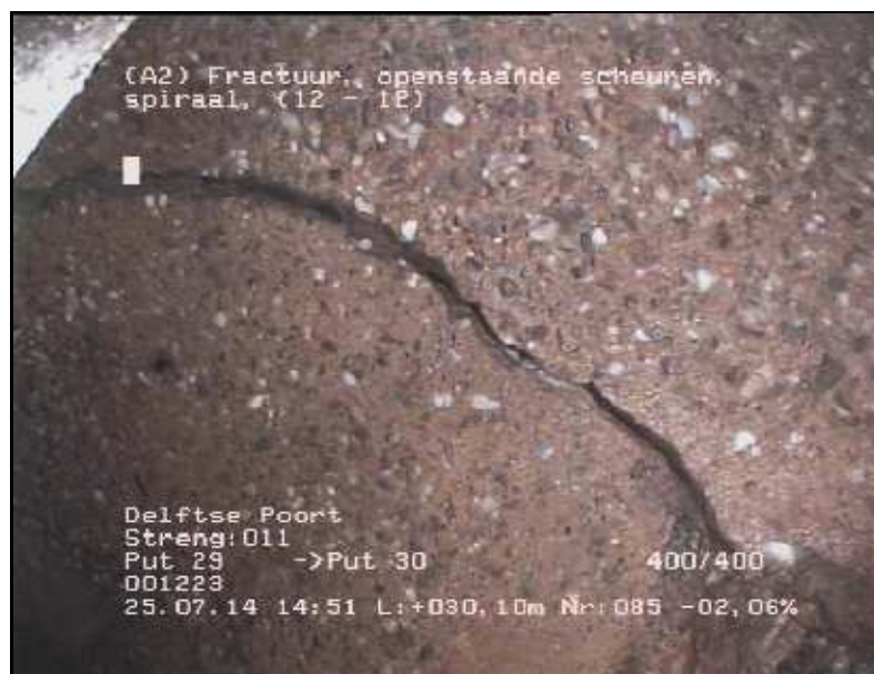
FOTO 085 30.10 m Video DVD01 Fractuur, openstaande scheuren, spiraal
