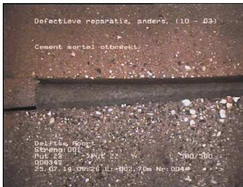
FOTO 004 2.70 m Video DVD01 Defectieve reparatie, anders; Cement mortel otbreekt.
