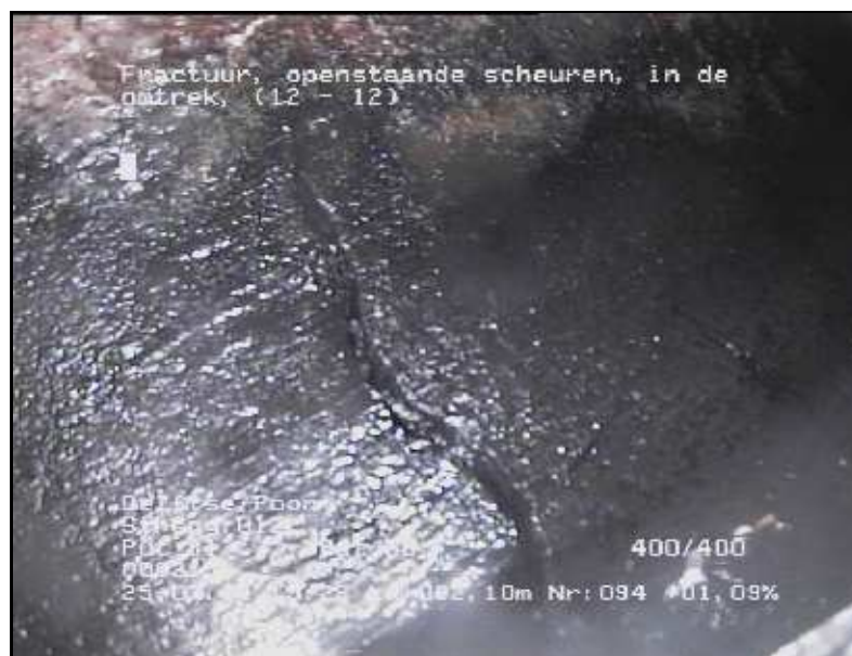
FOTO 094 2.10 m Video DVD01 Fractuur, openstaande scheuren, in de omtrek
