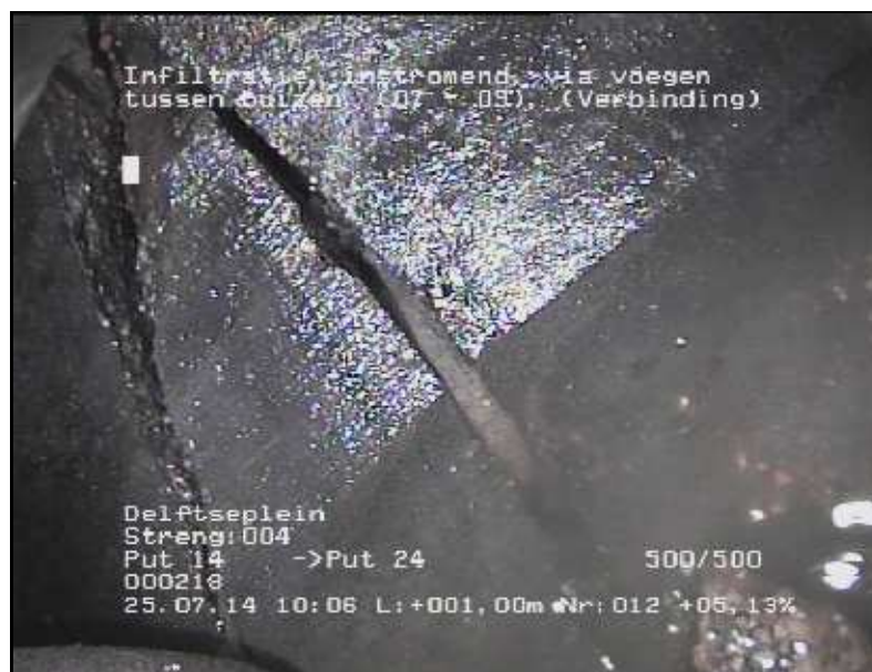
FOTO 012 1.00 m Video DVD01 Infiltratie, instromend, via voegen tussen buizen
