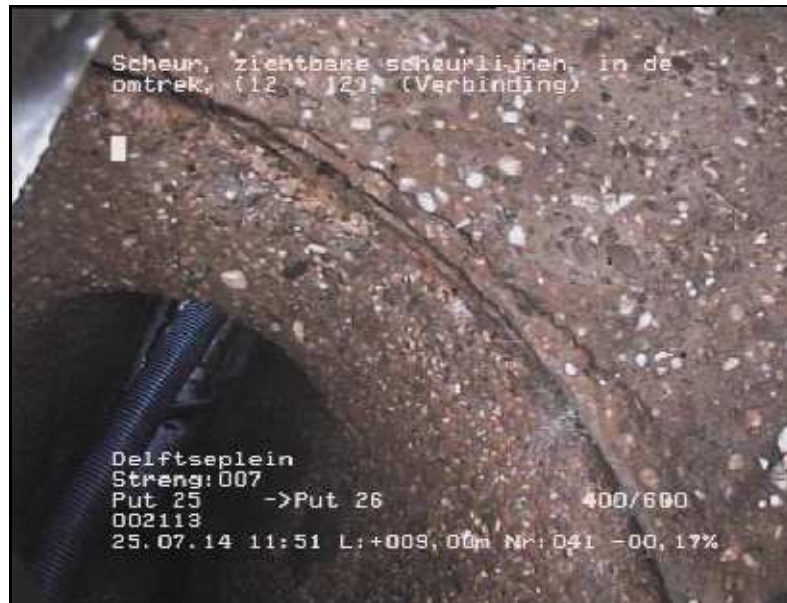
FOTO 041 9.00 m Video DVD01 Infiltratie, doorzweten, via scheuren / barsten / breuken
