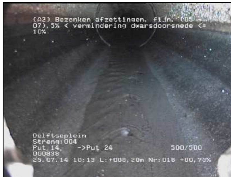
FOTO 018 8.20 m Video DVD01 Bezonken afzettingen, fijn, 5% < vermindering dwarsdoorsnede <= 10%
