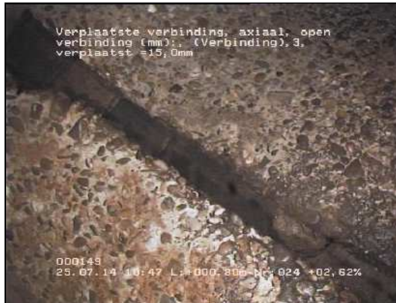
FOTO 024 0.80 m Video DVD01 Infiltratie, doorzweten, via voegen tussen buizen
