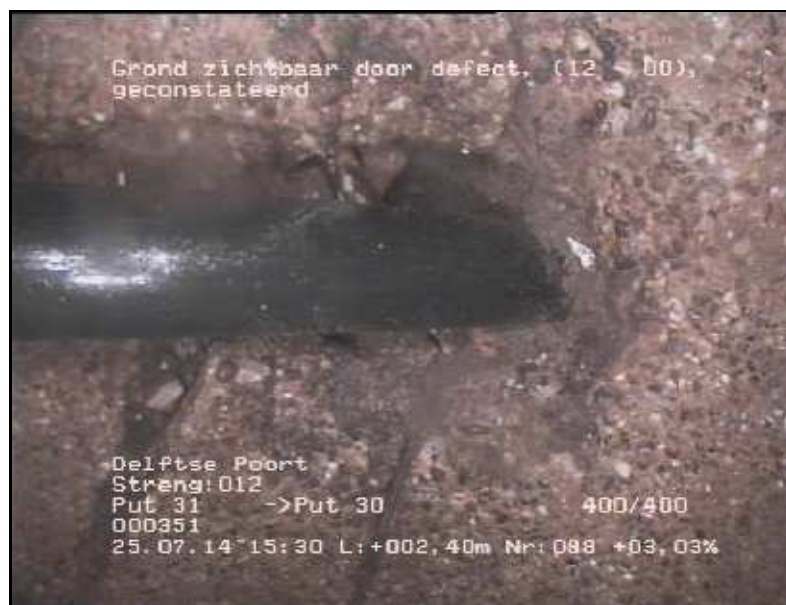
FOTO 098 2.40 m Video DVD01 Grond zichtbaar door defect, geconstateerd
