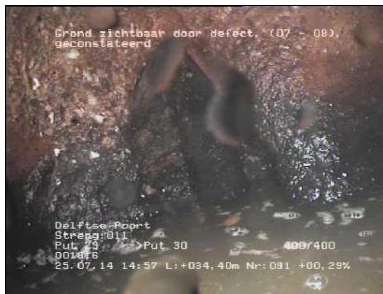
FOTO 091 34.40 m Video DVD01 Grond zichtbaar door defect, geconstateerd
