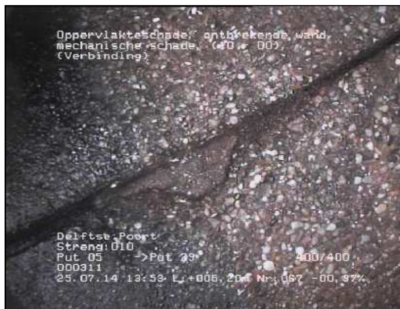
FOTO 067 5.20 m Video DVD01 Oppervlakteschade, ontbrekende wand, mechanische schade
