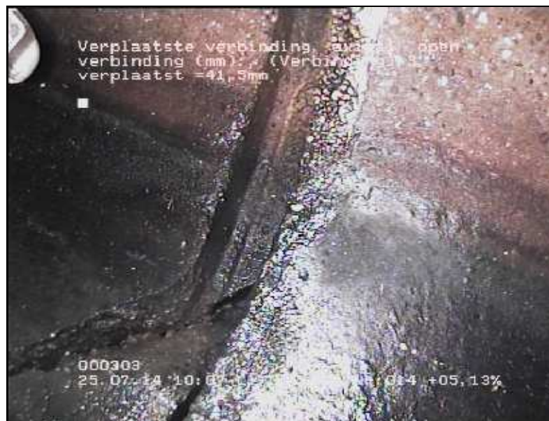
FOTO 014 1.00 m Video DVD01 Verplaatste verbinding, axiaal, open verbinding (mm): 3, verplaatst = 41,50mm
