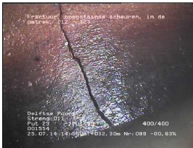
FOTO 089 32.30 m Video DVD01 Fractuur, openstaande scheuren, in de omtrek
