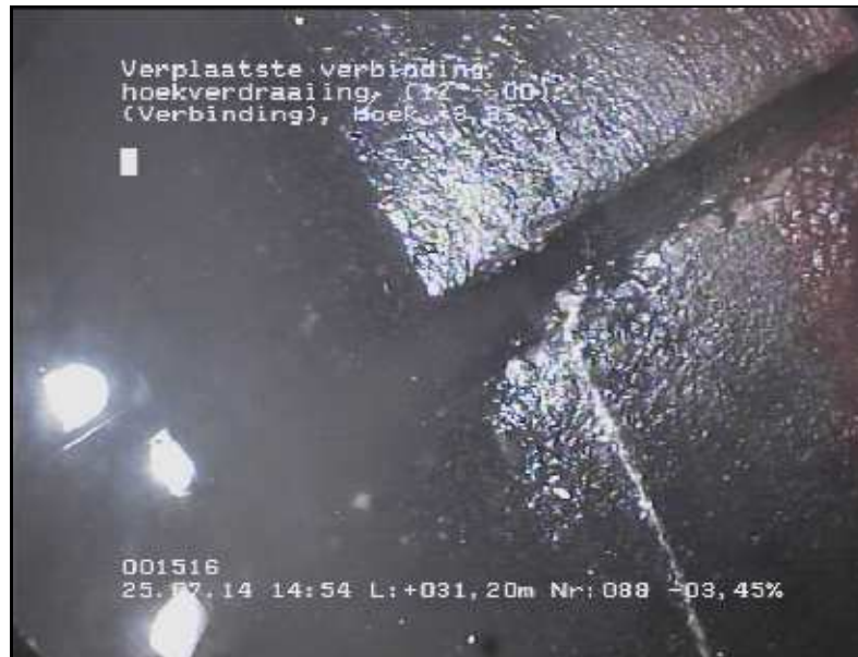
FOTO 088 31.20 m Video DVD01 Verplaatste verbinding, hoekverdraaiing, Hoek = 3,30°
