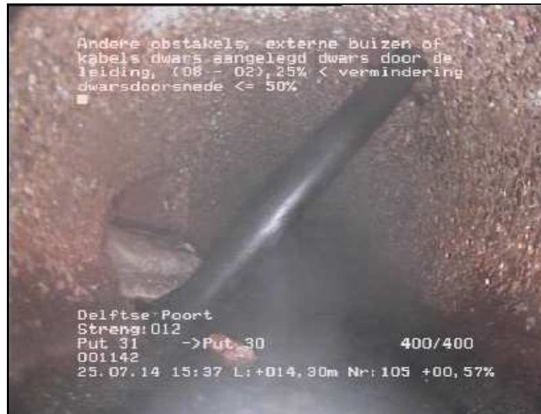
FOTO 105 14.30 m Video DVD01 Andere obstakels, externe buizen of kabels dwars aangelegd dwars door de leiding, 25% < vermindering dwarsdoorsnede <= 50%
