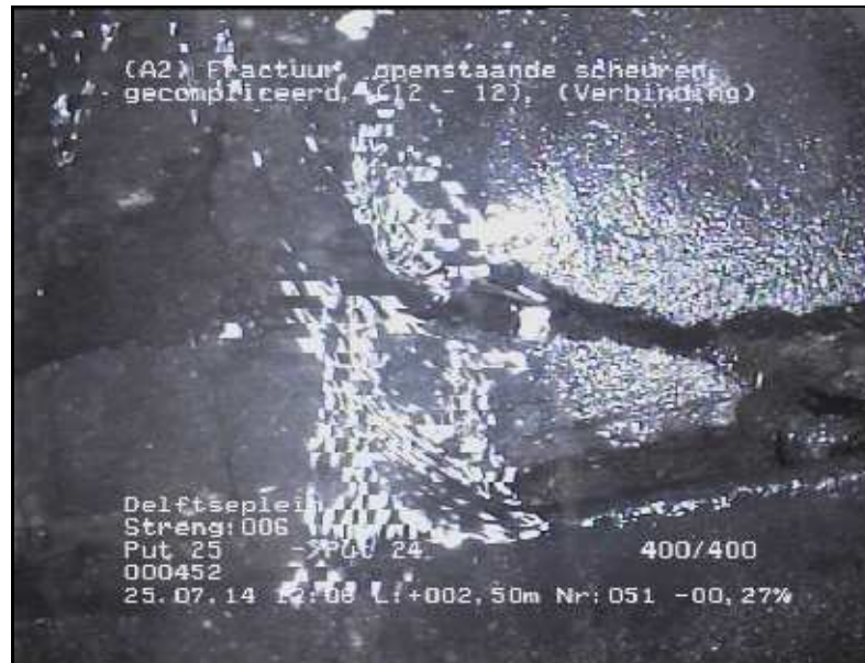
FOTO 051 2.50 m Video DVD01 Fractuur, openstaande scheuren, gecompliceerd
