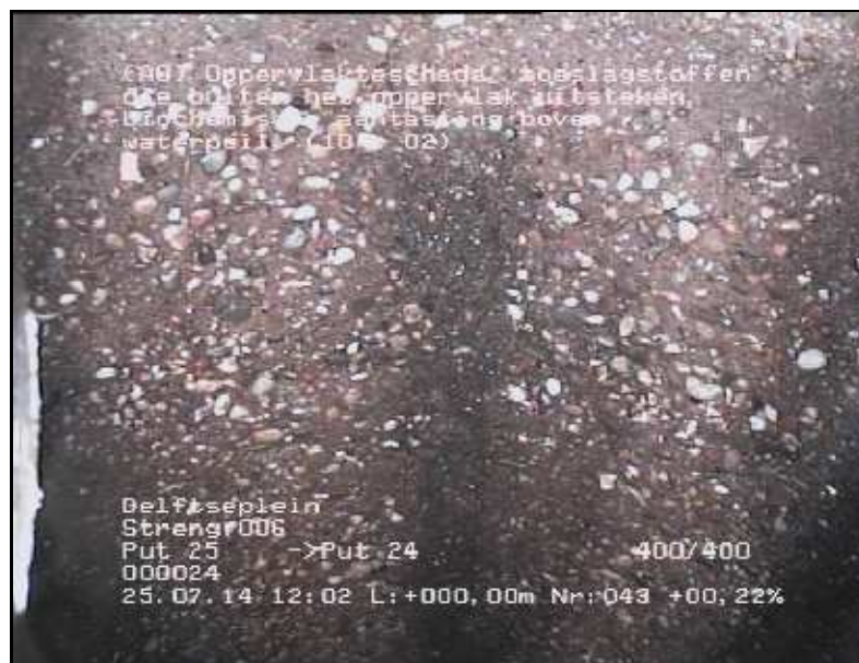
FOTO 043 0.00 m Video DVD01 Oppervlakteschade, toeslagstoffen die buiten het oppervlak uitsteken, biochemische aantasting boven waterpeil
