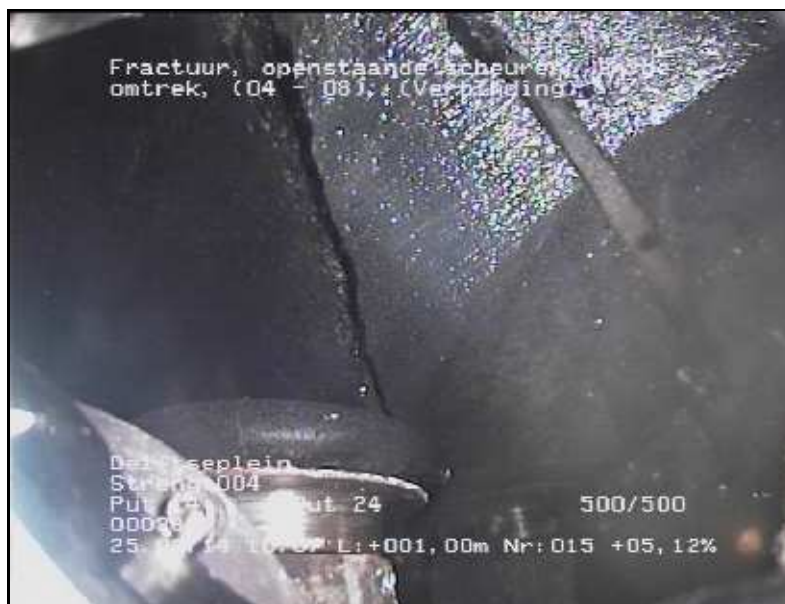
FOTO 015 1.00 m Video DVD01 Fractuur, openstaande scheuren, in de omtrek
