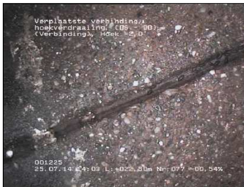
FOTO 077 22.50 m Video DVD01 Verplaatste verbinding, hoekverdraaiing, Hoek = 2°
