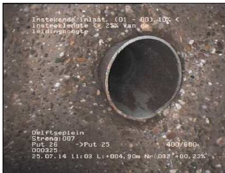
FOTO 032 4.90 m Video DVD01 Instekende inlaat, 10% < insteeklengte <= 25% van de leidinghoogte
