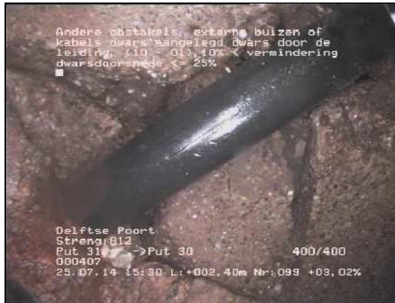
FOTO 099 2.40 m Video DVD01 Andere obstakels, externe buizen of kabels dwars aangelegd dwars door de leiding, 10% < vermindering dwarsdoorsnede <= 25%
