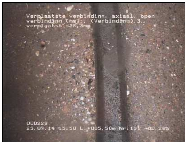
FOTO 111 5.50 m Video DVD01 Verplaatste verbinding, axiaal, open verbinding (mm):, 3, verplaatst = 38,30mm
