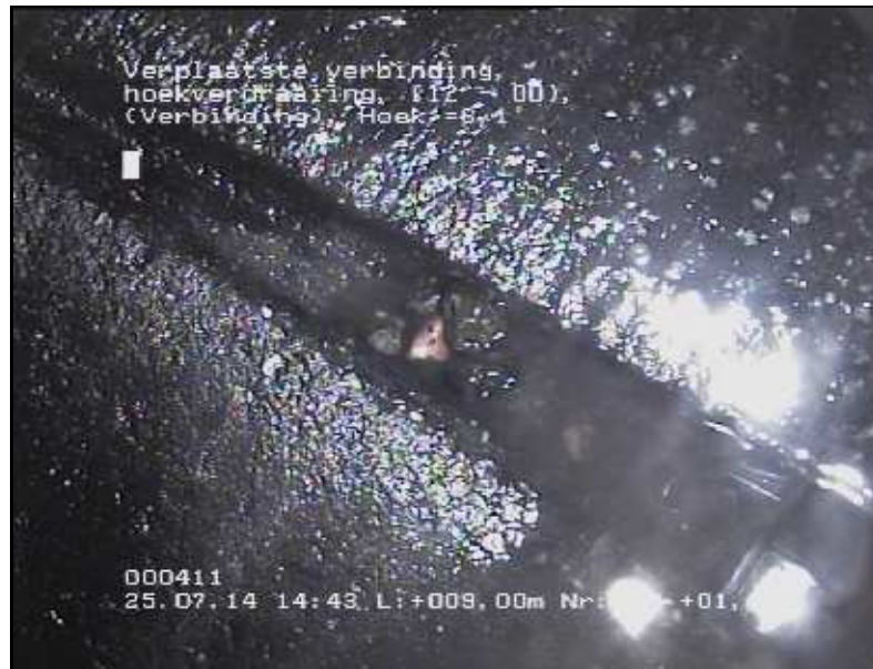
FOTO 080 9.00 m Video DVD01 Verplaatste verbinding, hoekverdraaiing, Hoek = 6,10°
