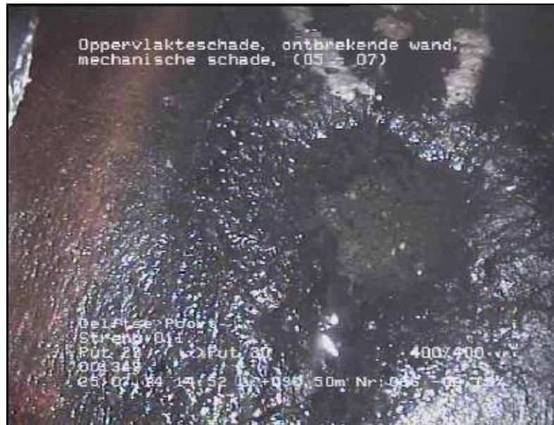
FOTO 086 30.50 m Video DVD01 Grond zichtbaar door defect, geconstateerd
