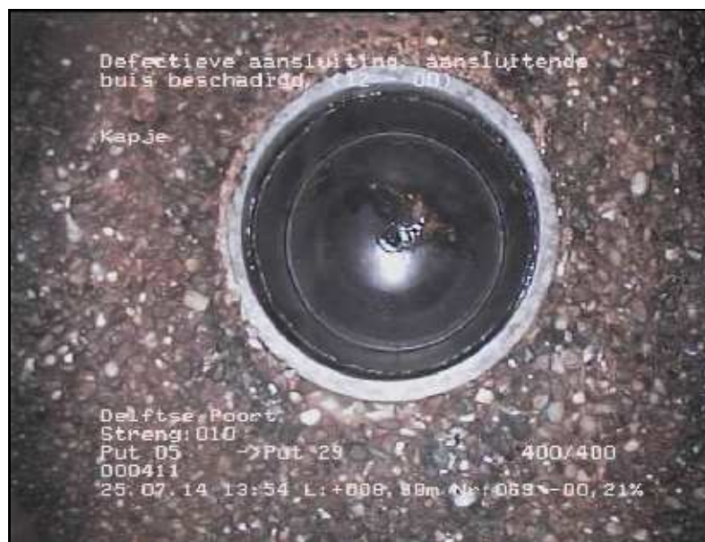
FOTO 069 6.90 m Video DVD01 Defectieve aansluiting, aansluitende buis beschadigd; Kapje
