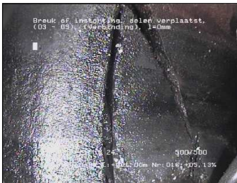
FOTO 016 1.00 m Video DVD01 Break of instorting, delen verplaatst, lengte = 0mm
