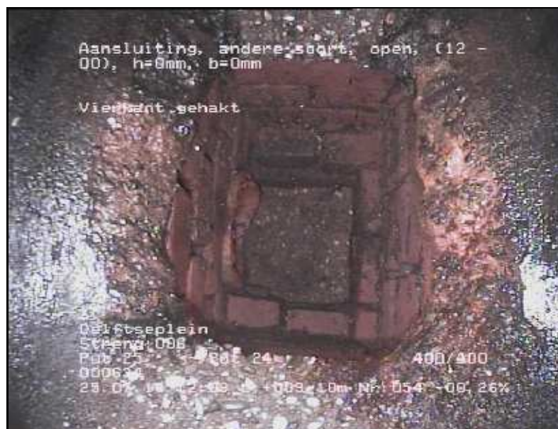
FOTO 054 3.10 m Video DVD01 Aansluiting, andere soort, open, hoogte = 0mm, breedte = 0mm; Vierkant gehakt
