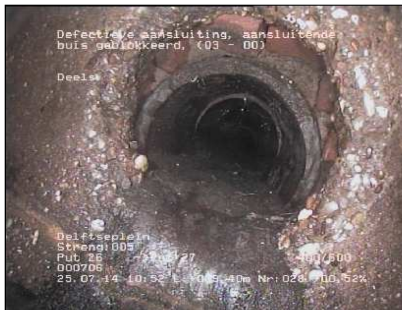
FOTO 028 9.40 m Video DVD01 Defectieve aansluiting, aansluitende buis geblokkeerd; Deels
