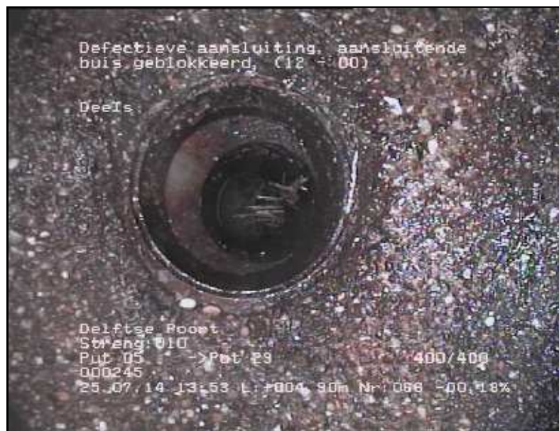
FOTO 066 4.90 m Video DVD01 Defectieve aansluiting, aansluitende buis geblokkeerd; Deels
