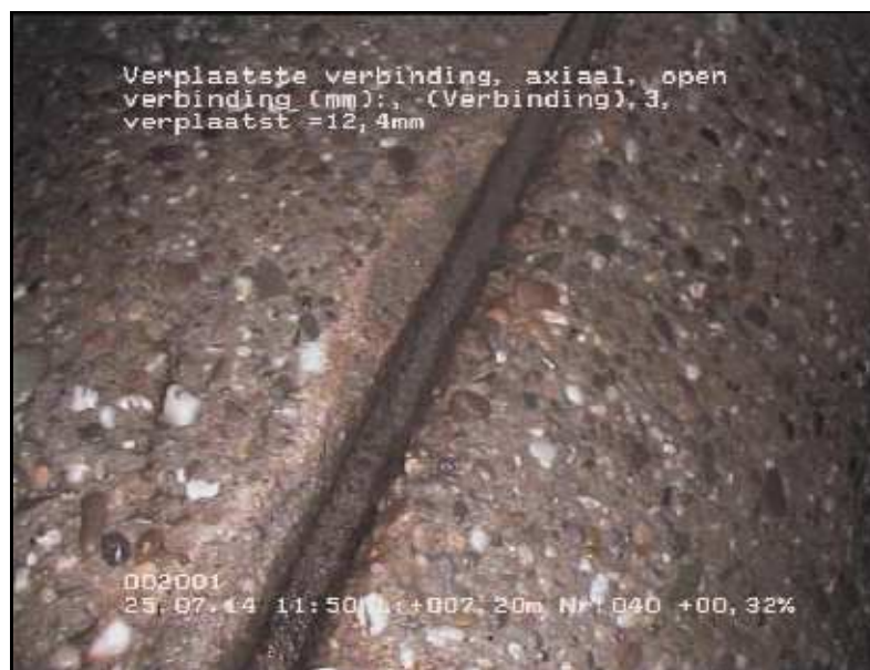
FOTO 040 8.70 m Video DVD01 Aansluiting, vlakke aansluiting - gebeiteld, open, hoogte = 0mm, breedte = 0mm
