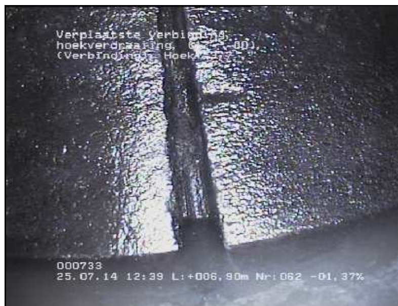
FOTO 062 6.90 m Video DVD01 Verplaatste verbinding, hoekverdraaiing, Hoek = 3,70°
