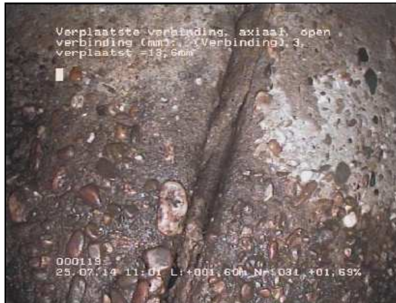
FOTO 031 1.60 m Video DVD01 Verplaatste verbinding, axiaal, open verbinding (mm):, 3, verplaatst = 13,60mm
