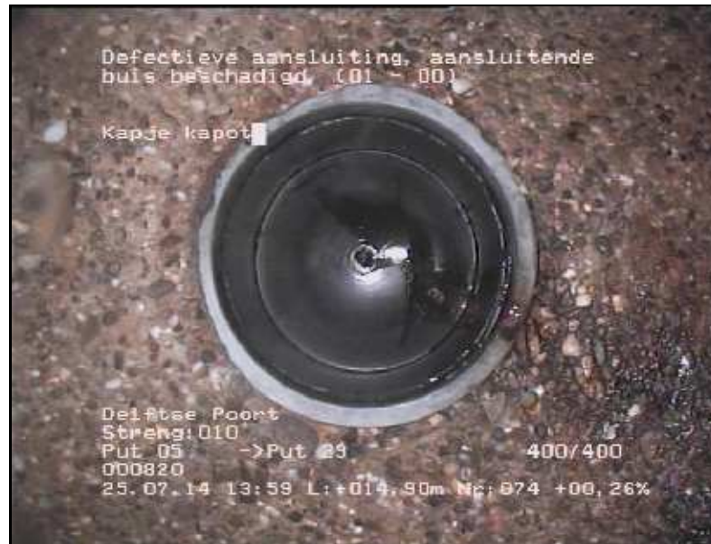
FOTO 074 14.90 m Video DVD01 Defectieve aansluiting, aansluitende buis beschadigd; Kapje kapot
