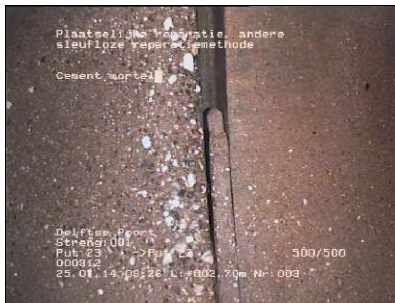
FOTO 003 2.70 m Video DVD01 Plaatselijke reparatie, andere sleufloze reparatiemethode; Cement mortel
