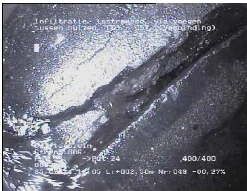
FOTO 049 2.50 m Video DVD01 Infiltratie, instromend, via voegen tussen buizen
