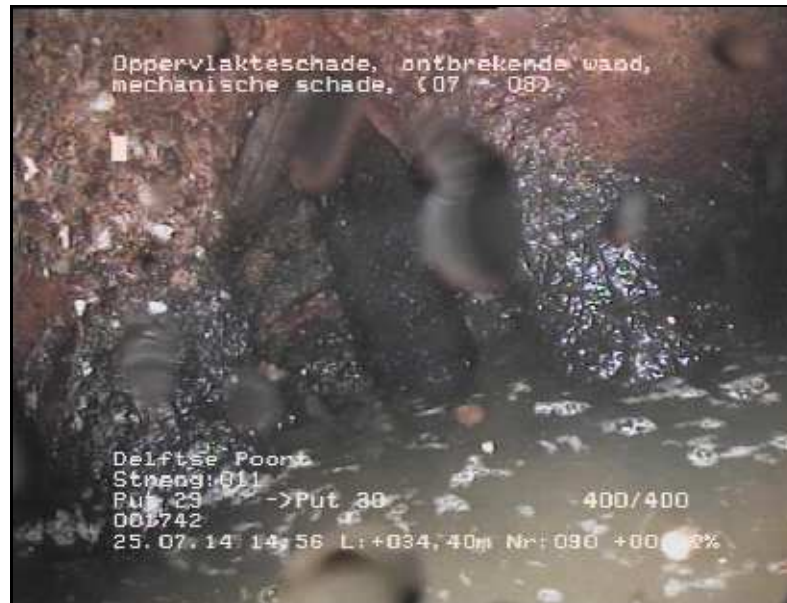
FOTO 090 34.40 m Video DVD01 Oppervlakteschade, ontbrekende wand, mechanische schade
