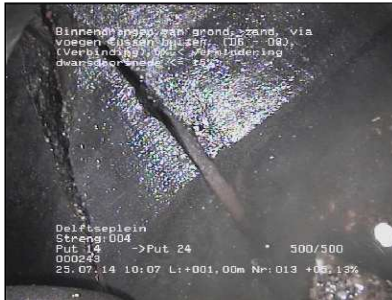
FOTO 013 1.00 m Video DVD01 Binnendringen van grond, zand, via voegen tussen buizen, 5% < vermindering dwarsdoorsnede <= 15%
