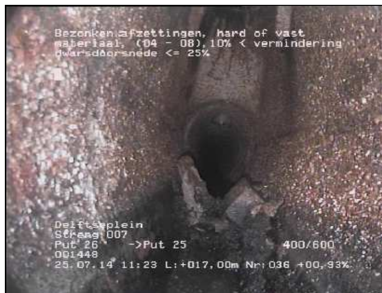
FOTO 036 17.00 m Video DVD01 Bezonken afzettingen, hard of vast materiaal, 10% < vermindering dwarsdoorsnede <= 25%
