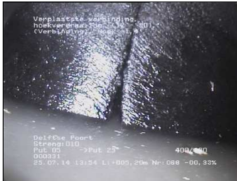
FOTO 068 5.20 m Video DVD01 Verplaatste verbinding, hoekverdraaiing, Hoek = 1,40°
