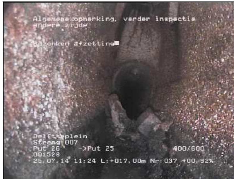
FOTO 037 17.00 m Video DVD01 Algemene opmerking, verder inspectie andere zijde; Bezonken afzetting
