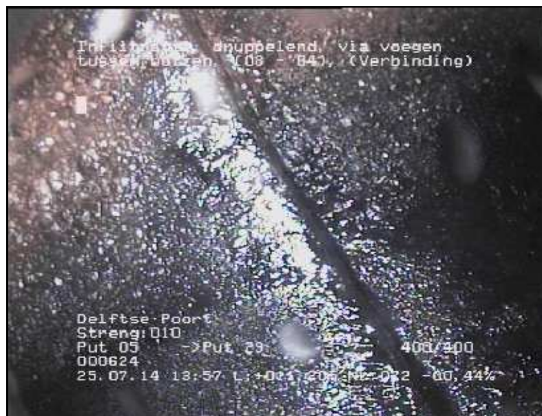
FOTO 072 11.20 m Video DVD01 Infiltratie, druppelend, via voegen tussen buizen
