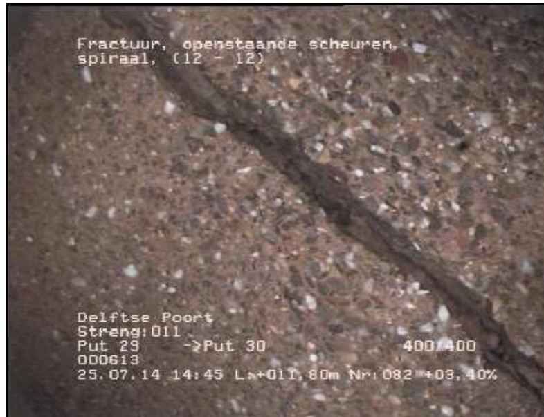
FOTO 082 11.80 m Video DVD01 Fractuur, openstaande scheuren, spiraal
