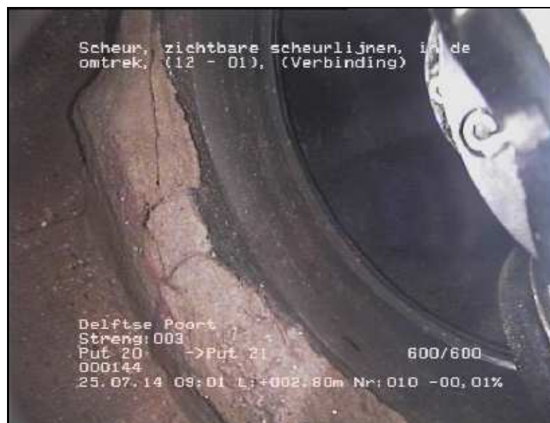
FOTO 010 2.80 m Video DVD01 Scheur, zichtbare scheurlijnen, in de omtrek
