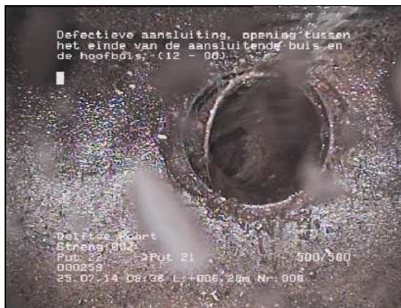
FOTO 008 6.20 m Video DVD01 Defectieve aansluiting, opening tussen het einde van de aansluitende buis en de hoofbuis
