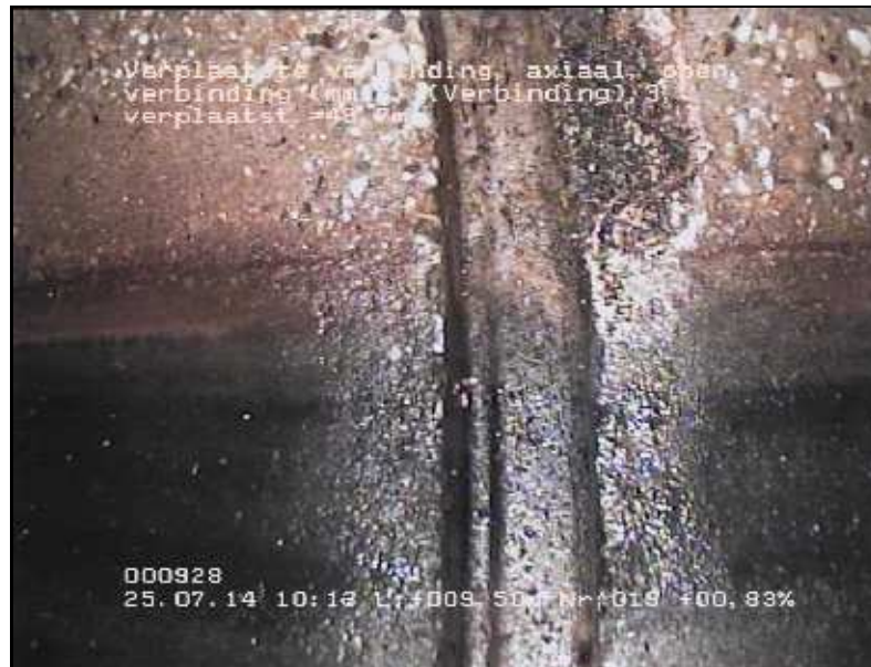
FOTO 019 9.50 m Video DVD01 Verplaatste verbinding, axiaal, open verbinding (mm):, 3, verplaatst = 49,70mm
