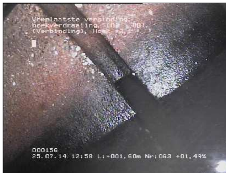
FOTO 063 1.60 m Video DVD01 Verplaatste verbinding, hoekverdraaiing, Hoek = 3,10°
