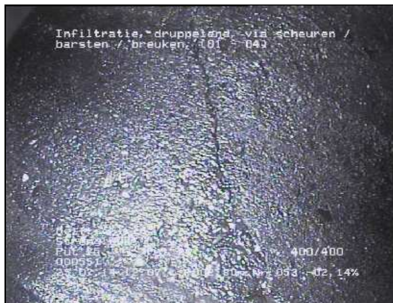
FOTO 053 3.00 m Video DVD01 Fractuur, openstaande scheuren, gecompliceerd
