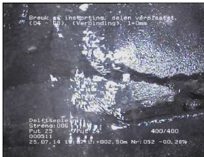
FOTO 052 2.50 m Video DVD01 Breuk of instorting, delen verplaatst, lengte = 0mm
