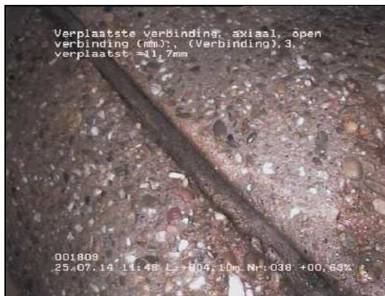
FOTO 038 4.10 m Video DVD01 Verplaatste verbinding, axiaal, open verbinding (mm):, 3, verplaatst = 11,70mm
