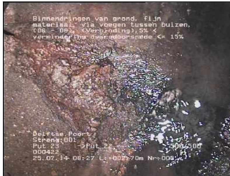
FOTO 005 2.70 m Video DVD01 Binnendringen van grond, fijn materiaal, via voegen tussen buizen, 5% < vermindering dwarsdoorsnede <= 15%
