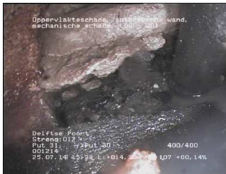
FOTO 107 14.30 m Video DVD01 Oppervlakteschade, ontbrekende wand, mechanische schade
