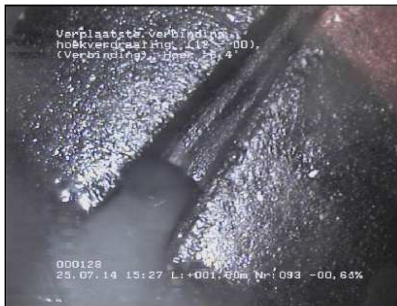
FOTO 093 1.80 m Video DVD01 Verplaatste verbinding, hoekverdraaiing, Hoek = 6,40°
