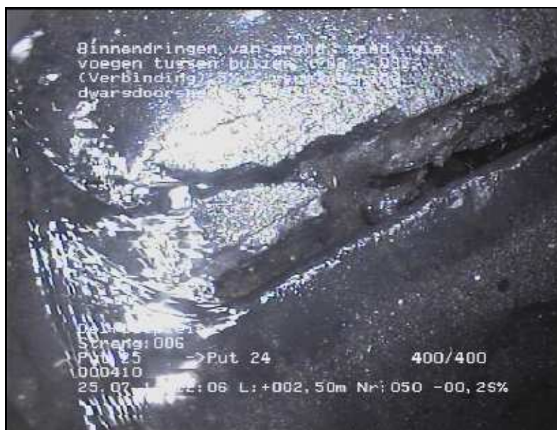
FOTO 050 2.50 m Video DVD01 Binnendringen van grond, zand, via voegen tussen buizen, 5% < vermindering dwarsdoorsnede <= 15%
