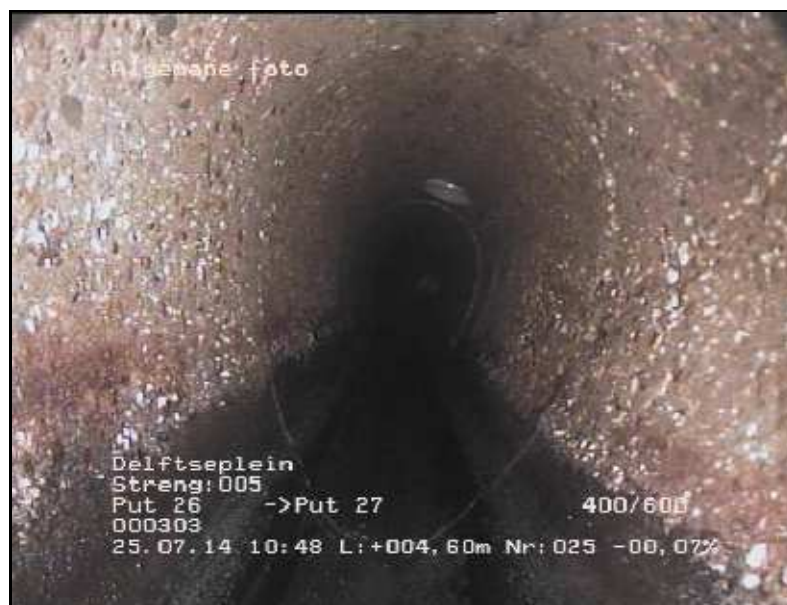
FOTO 025 5.80 m Video DVD01 Aansluiting, vlakke aansluiting - geboord, open, hoogte = 0mm, breedte = 0mm
