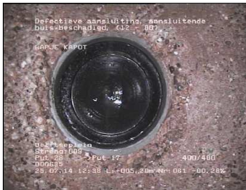
FOTO 061 5.20 m Video DVD01 Defectieve aansluiting, aansluitende buis beschadigd; Kapje kapot
