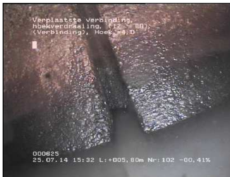
FOTO 102 5.80 m Video DVD01 Verplaatste verbinding, hoekverdraaiing, Hoek = 4°
