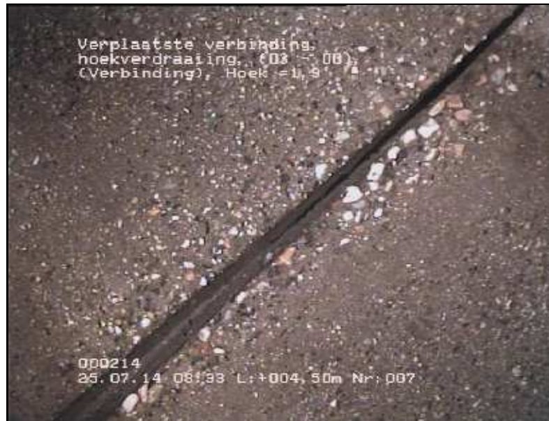
FOTO 007 4.50 m Video DVD01 Verplaatste verbinding, hoekverdraaiing, Hoek = 1,90°
