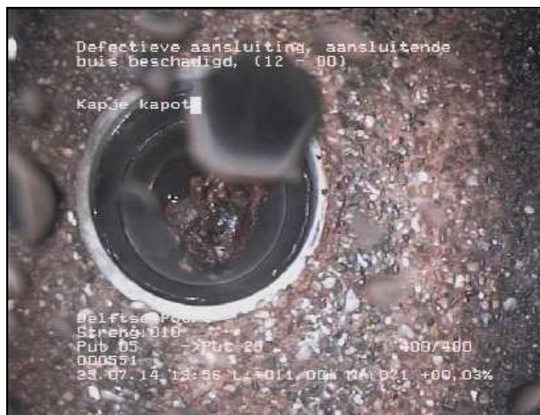
FOTO 071 11.00 m Video DVD01 Defectieve aansluiting, aansluitende buis beschadigd; Kapje kapot
