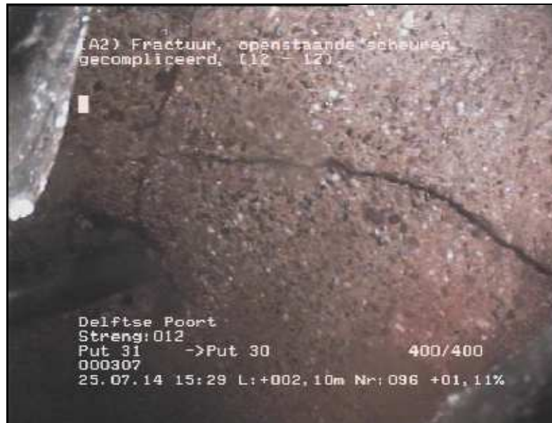
FOTO 096 2.10 m Video DVD01 Fractuur, openstaande scheuren, gecompliceerd
