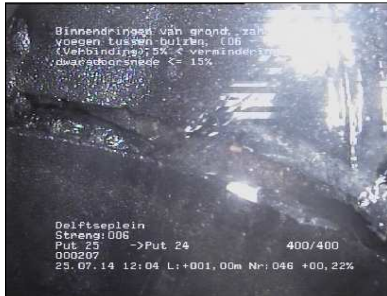
FOTO 046 1.00 m Video DVD01 Binnendringen van grond, zand, via voegen tussen buizen, 5% < vermindering dwarsdoorsnede <= 15%
