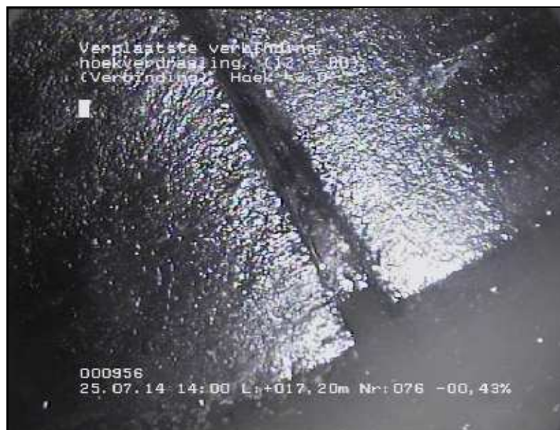
FOTO 076 17.20 m Video DVD01 Verplaatste verbinding, hoekverdraaiing, Hoek = 3°
