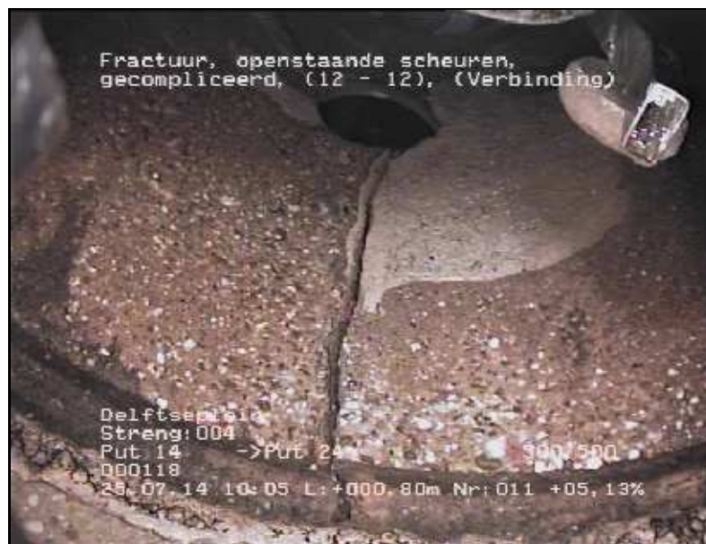
FOTO 011 0.80 m Video DVD01 Fractuur, openstaande scheuren, gecompliceerd
