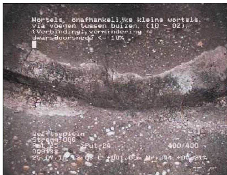
FOTO 044 1.00 m Video DVD01 Infiltratie, instromend, via voegen tussen buizen
