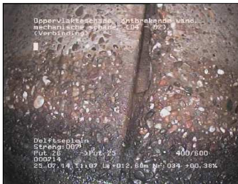
FOTO 034 12.60 m Video DVD01 Infiltratie, doorzweten, via voegen tussen buizen
