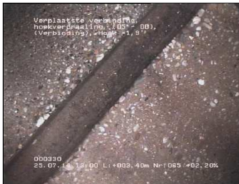
FOTO 065 3.40 m Video DVD01 Verplaatste verbinding, hoekverdraaiing, Hoek = 1,90°
