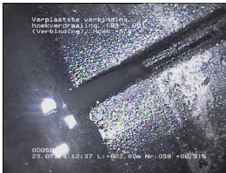
FOTO 058 2.80 m Video DVD01 Verplaatste verbinding, hoekverdraaiing, Hoek = 3,80°
