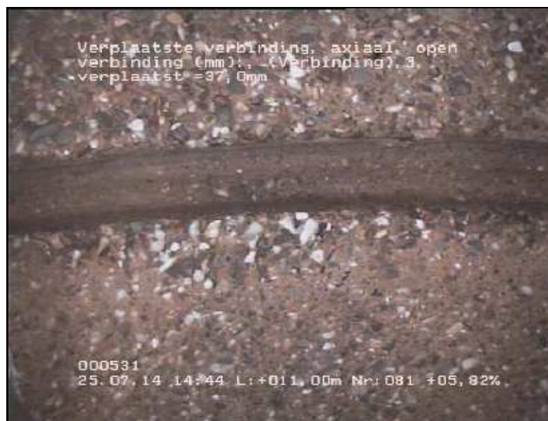
FOTO 081 11.00 m Video DVD01 Verplaatste verbinding, axiaal, open verbinding (mm):, 3, verplaatst = 37mm
