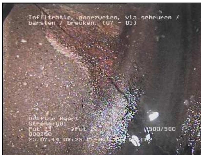
FOTO 002 1.90 m Video DVD01 Infiltratie, doorzweeten, via scheuren / barsten / breuken
