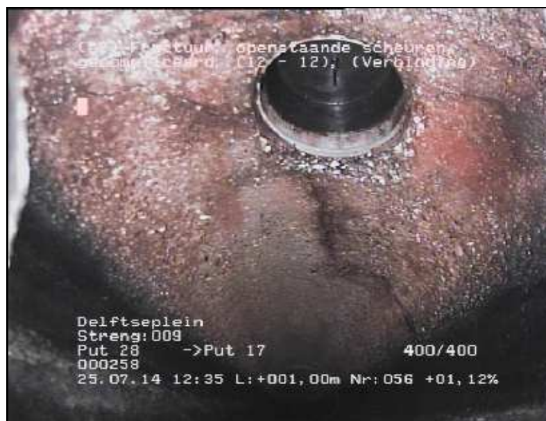
FOTO 056 1.00 m Video DVD01 Fractuur, openstaande scheuren, gecompliceerd
