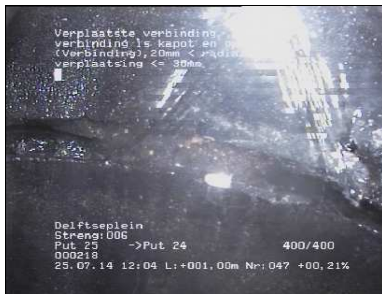
FOTO 047 1.00 m Video DVD01 Verplaatste verbinding, radiaal, verbinding is kapot en open, 20mm < radiale verplaatsing <= 30mm
