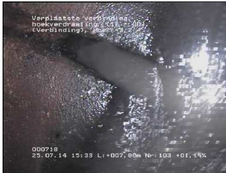
FOTO 103 7.80 m Video DVD01 Verplaatste verbinding, hoekverdraaiing, Hoek = 5,20°
