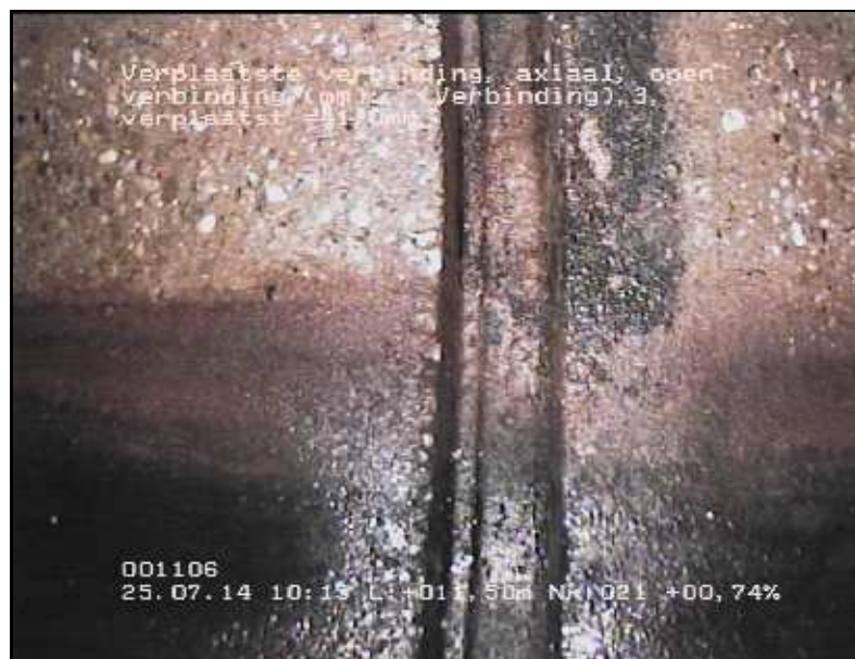
FOTO 021 11.50 m Video DVD01 Verplaatste verbinding, axiaal, open verbinding (mm): 3, verplaatst = 41mm
