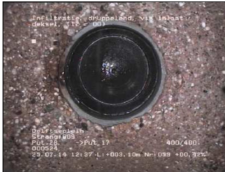
FOTO 059 3.10 m Video DVD01 Infiltratie, druppelend, via inlaat deksel
